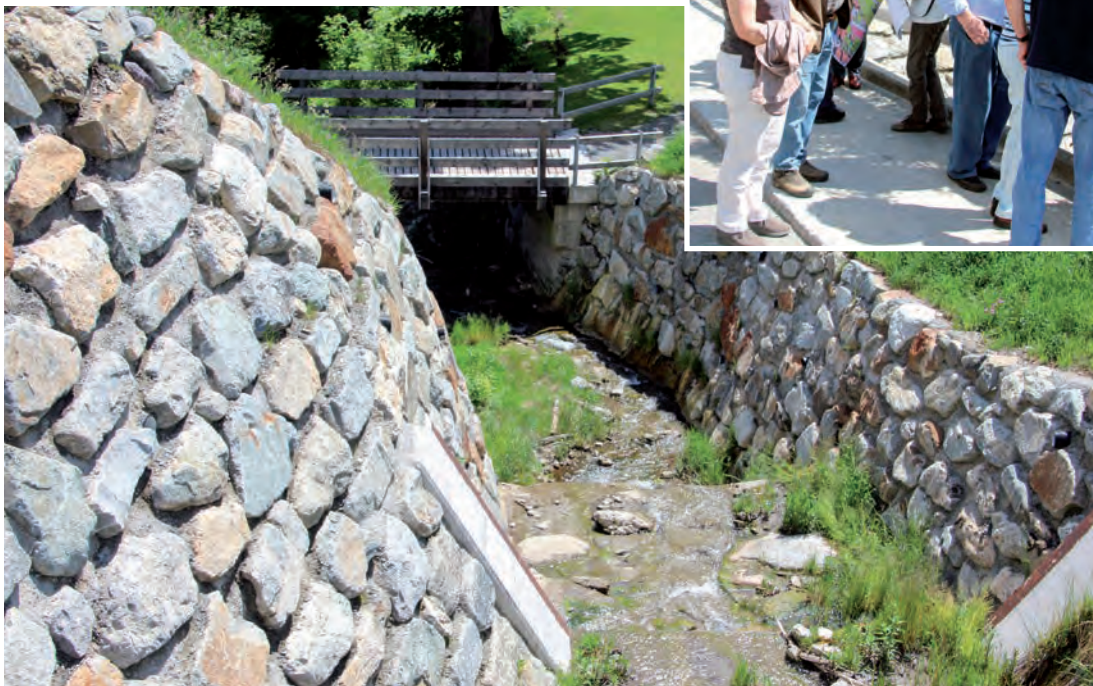
Dank der Verbauungen sind Bewohner und Besucher wieder in Sicherheit.
